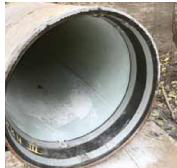
Abb. 6: Sanierungsergebnis nach Einbringung und Aushärtung eines harzgetränkten Glasfaserschlauchs
