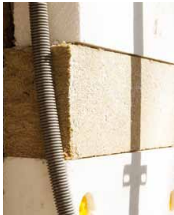
Abb. 3: WDVS mit Polystyrol-Dämmung und Brandriegel, Detail
