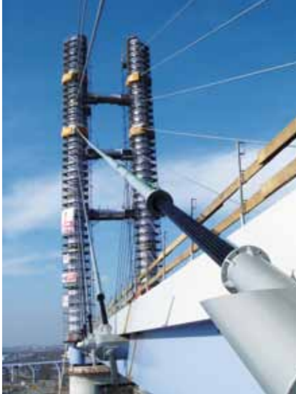
Abb. 2: Gespannte Schrägeillitzen
