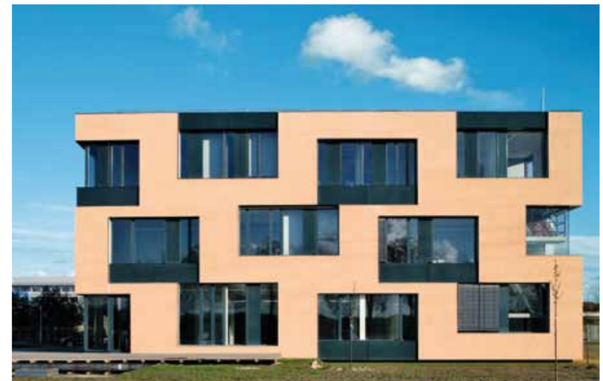
Abb. 6: Vorgehängte hinterlüftete Fassade
