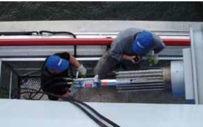
Abb. 1: Spannen der Schrägeillitzen
